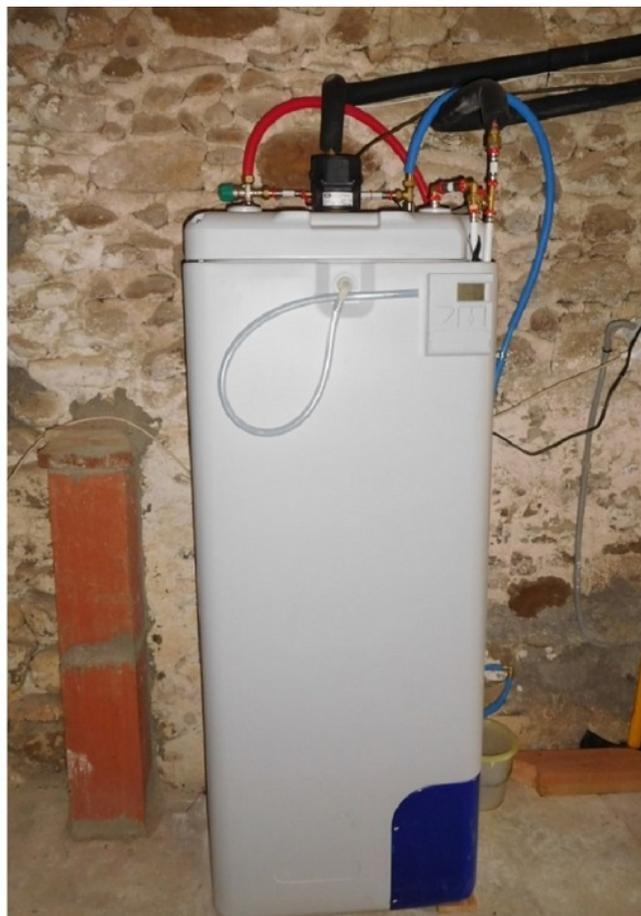
*Installation d'un chauffe eau solaire fonctionnant en auto-vidange avec 2 capteurs. L'implantation verticale permet dans ce cas la meilleure exposition et une meilleure production en hiver que sur le toit exposé sud dont la pente est faible. Pas de glycool ni de surchauffe en été car quand la pompe qui fait circuler l'eau dans les capteurs est arrêtée, ces derniers se vident.*
