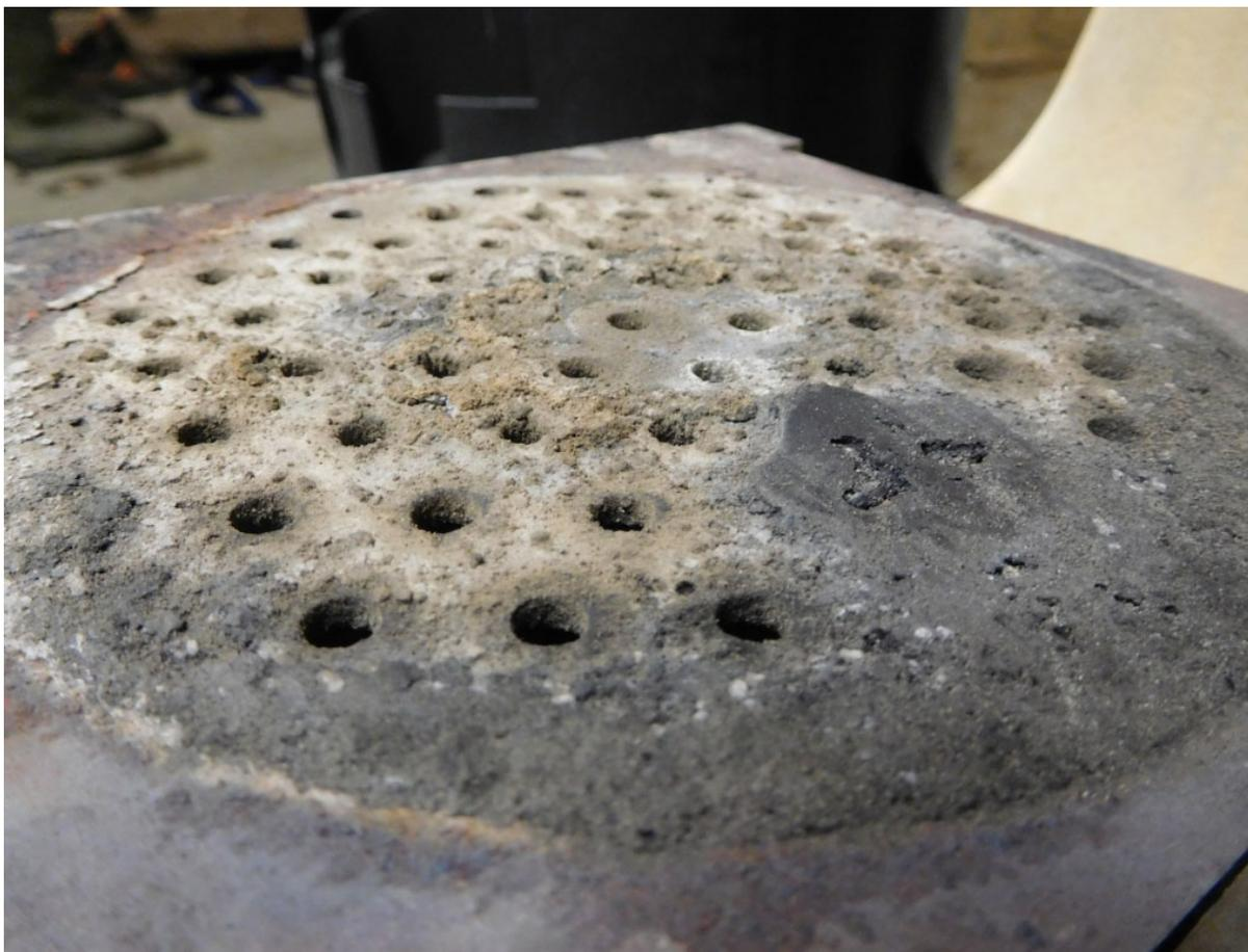
*Entretien annuel d'une chaudière à granulés de bois Froling P4 25 kW : nettoyage complet, et vérification de l'état des organes sensibles, mise à jour du logiciel et de l'affichage, analyse de combustion et vérification du bon fonctionnement.*
