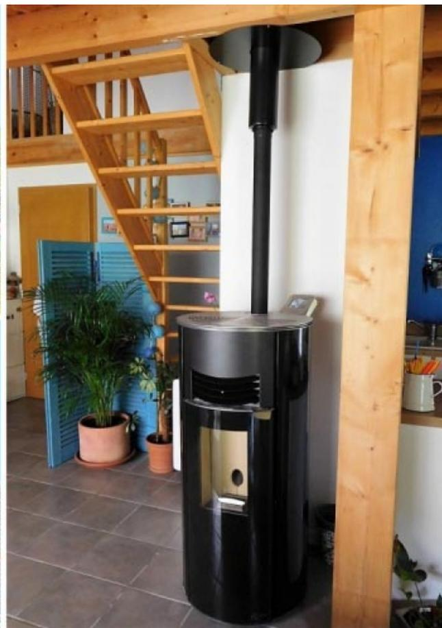
*Remplacement d'un poêle à granulé et de son conduit de fumées, remise aux normes des distances de sécurité et remise en état de l'étanchéité et de l'enveloppe isolante de la toiture. La marque de l'ancien poêle n'existe plus, il était bruyant, surdimensionné et doté d'une régulation sommaire. Le nouveau poêle est très facile d'utilisation, silencieux et étanche avec une prise d'air depuis l'extérieur pour répondre aux besoins de cette maison en RT 2012.*
