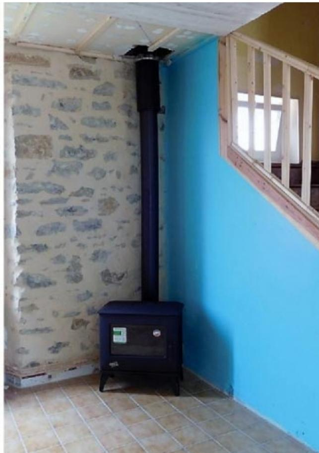
*Poêle Godin modèle "Cube" 6kW installé dans une maison en rénovation une diminution de la facture énergétique et pour plus d'agrément, en complément d'un chauffage central au gaz déjà présent. Création d'un conduit inox double paroi isolé pour l'évacuation des fumées dans le respect des normes de sécurité. A l'étage, le conduit a été protégé par un coffrage (non présenté sur les clichés)*
